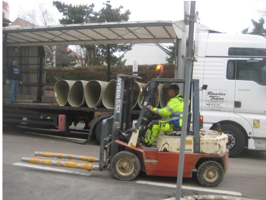
Rohrlieferung (2,3 m und 1,0 m)
