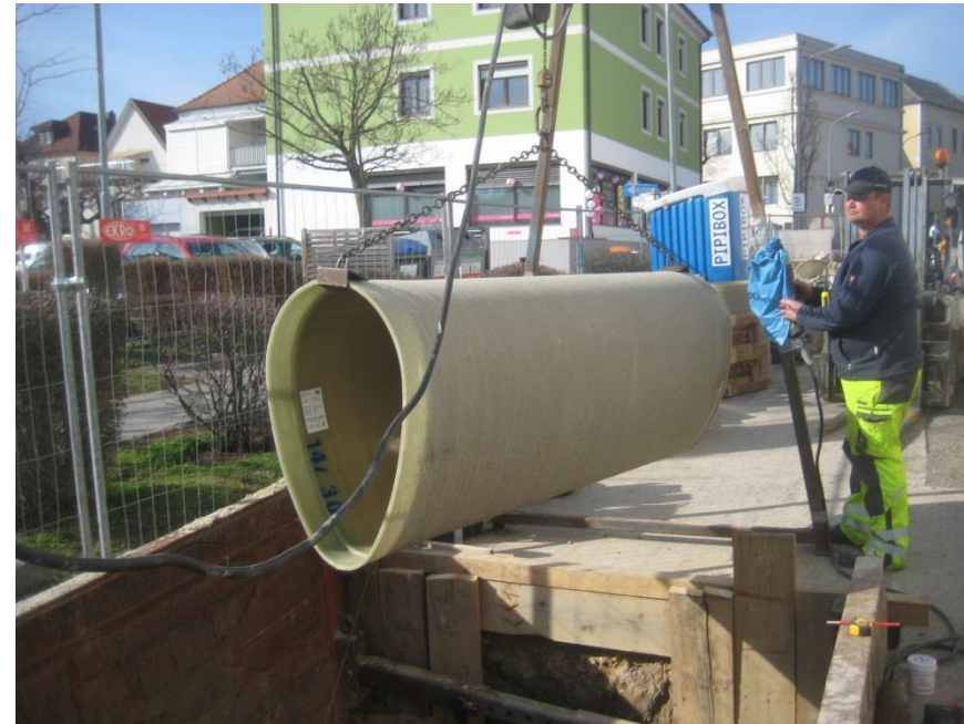
Einheben in Montagegrube
