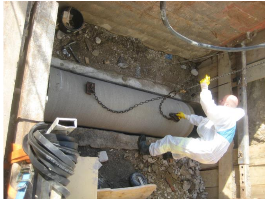
Einlegen in Altrohr, Ringspalt 38 mm
